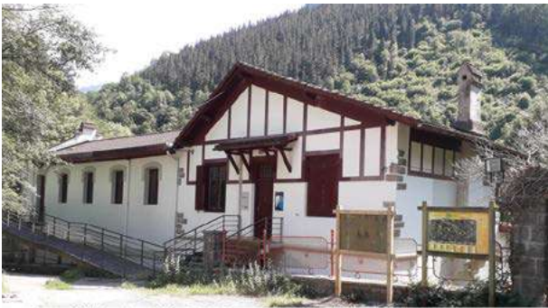
Central eléctrica de la C. A. F. en Arkaka, Zaldibia
