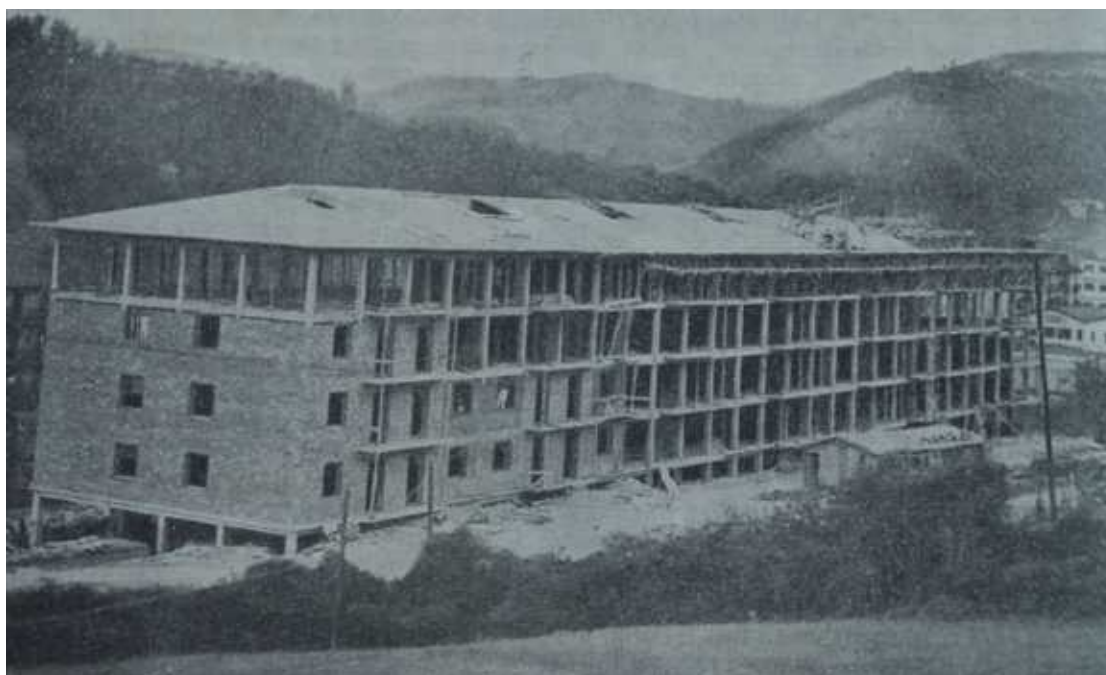
El bloque del 18 al 30 de la que inicialmente sería Calle "A del Nuevo Ensanche, más tarde Tercio de Oriamendi y hoy Oriamendi, en plena construcción en enero de 1955 (B.F.)
